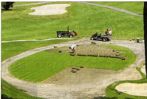
Eines der nagelneuen Greens im alten Teil von Bendinat. Das Foto unten entstand während der Bauphase: Der Rasen wird ausgerollt.
